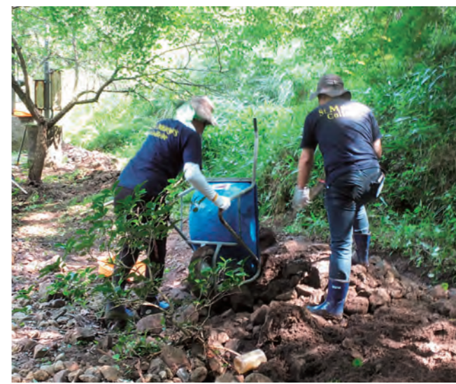
真夏の土砂の除去作業は熱中症との闘い
