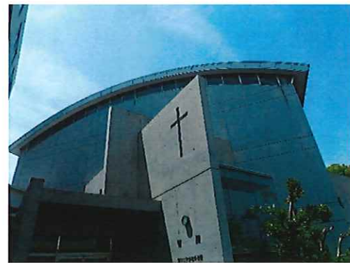
指定避難所となっている体育館
